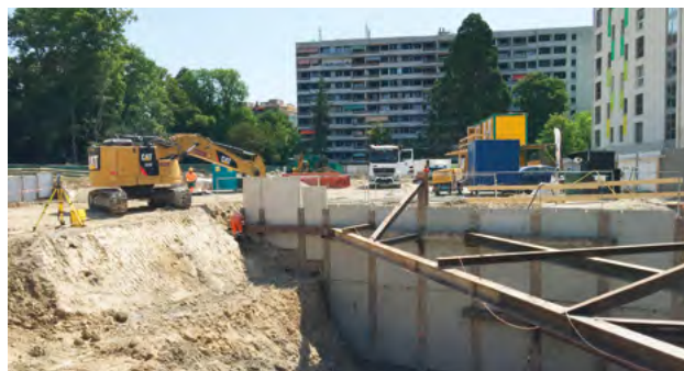
LA FORÊT: TRAVAUX DE TERRASSEMENT EN COURS
