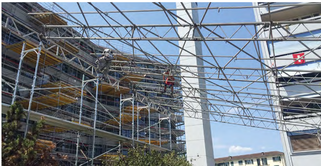
MONTAGE DE LA COUVERTURE PROVISOIRE DU CHANTIER DE RÉFECTION DES DALLES
