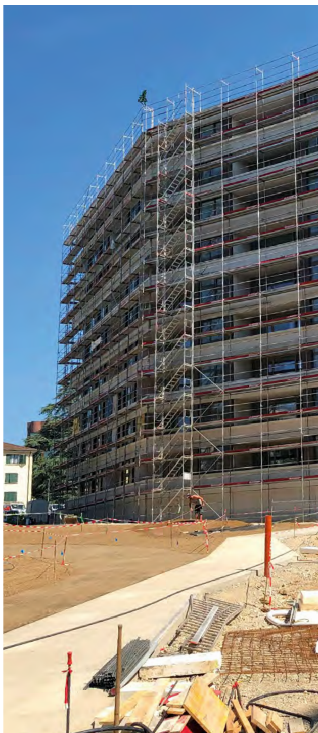
CHANTIER DU BÂTIMENT A
